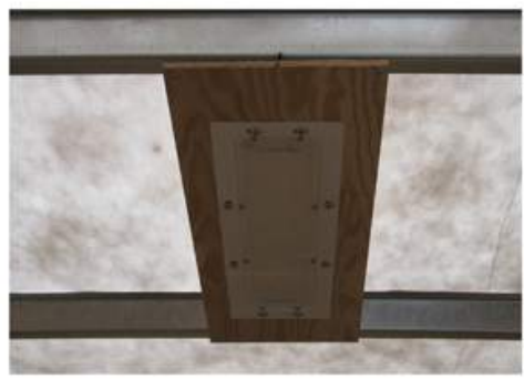
Plafonnier encastré de type Grote D.E.L. avec détecteur de présence à infrarouge (sans interrupteur)
