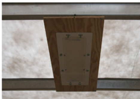
Plafonnier encastré de type Grote D.E.L. avec détecteur de présence à infrarouge (sans interrupteur)
